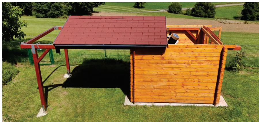
1 Die geöffnete Sternwarte in der Bauweise als Rolldachhütte während der Sonnenbeobachtung im Weißlicht.
